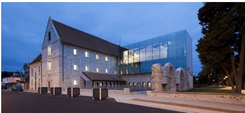
Fig. 35 - Fotografia do exterior da Escola de Música de Louviers (fonte: https://www.archdaily.com.br/br/01-109902/reabilitacao-e-ampliacao-da-escola-de-musica-de-louviers-slash-opus-5-architectes )
