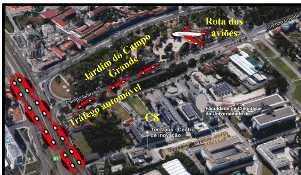
Figura 9.1.1 - Localização do edifício C8 da FCUL.
