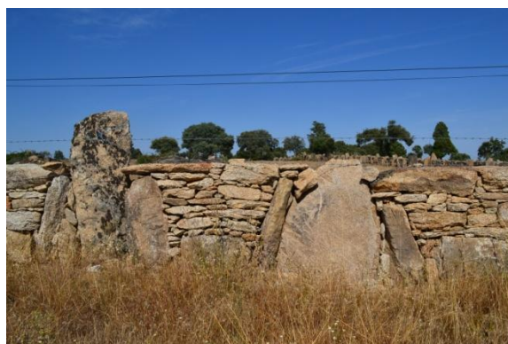
Muro tradicional construído por um dos agricultores inquirido
