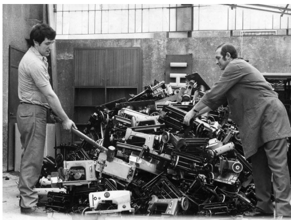
Fig. 3 - Necchi, Milão - “Demolição de máquinas dadas em permuta.” Não é sabido o motivo exacto para que estas máquinas de costura estejam a ser destruídas, mas podem distinguir-se diferentes marcas no grupo, entre elas a Anker e a Necchi.
