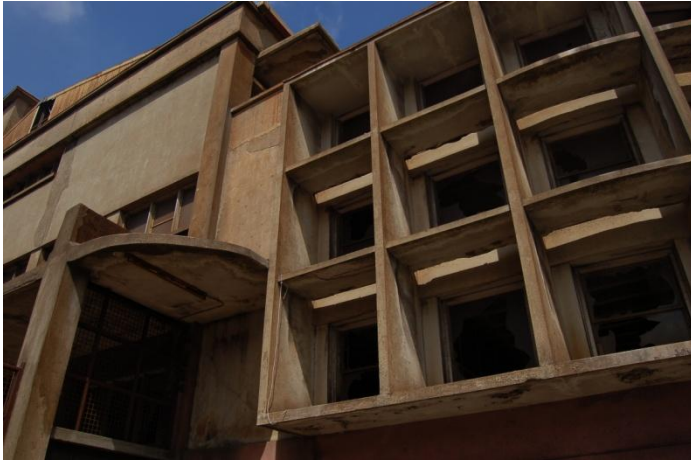
Fig.96 - Edifício Oliva na actualidade.
