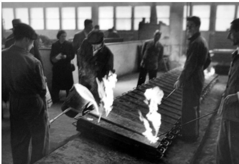
Fig. 82 - Colocação do ferro fundido nos moldes de aço.
