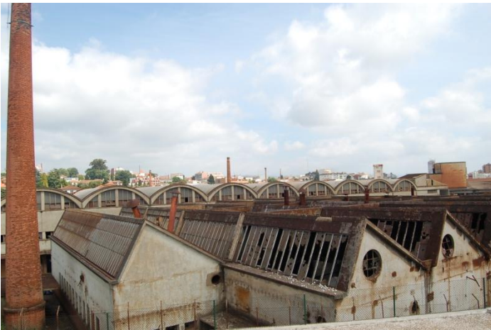
Fig. 97 - Edifício Oliva na actualidade.
