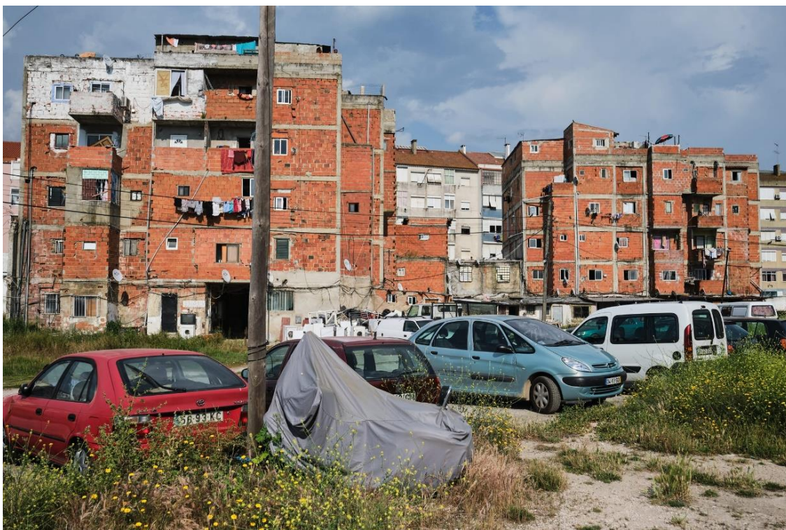
Figura 12- Construções ilegais do Bairro da Jamaica, Seixal, Fotografia por Rui Gaudêncio, 2020, Público
