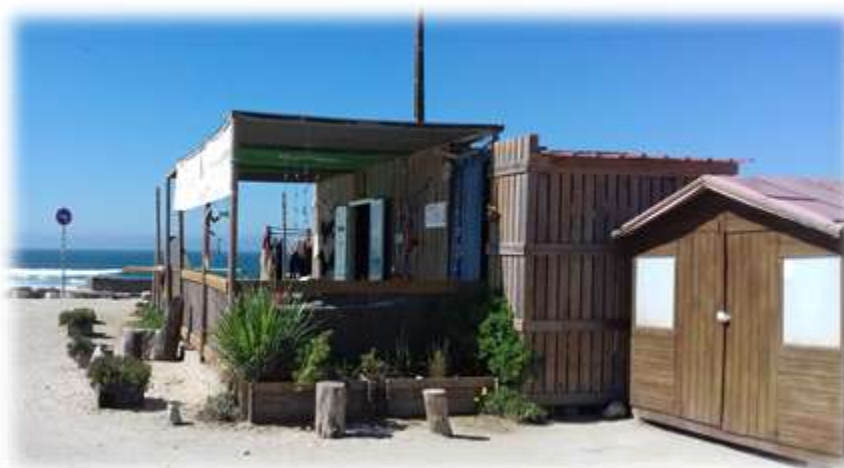
Figura 29 - Escola de Surf III - Instalação de Estrutura Amovível em área DPM - Figueira da Foz
