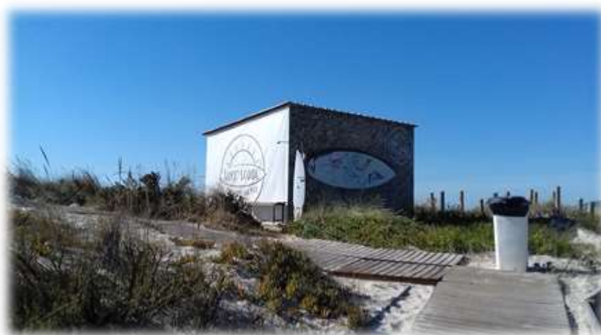
Figura 27 - Escola de Surf I - Instalação de Estrutura Amovível em área DPM - Figueira da Foz
