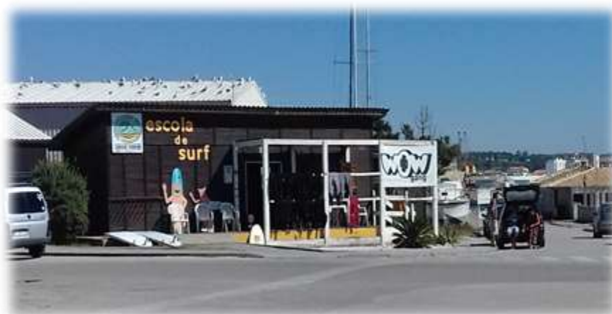
Figura 28 - Escola de Surf II - Instalação de Estrutura Amovível em área DPM - Figueira da Foz
