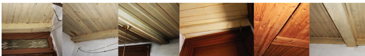
Figura 04.23 - Vigas mestras de sustentação do pavimento do pavimento, imagens da autora
