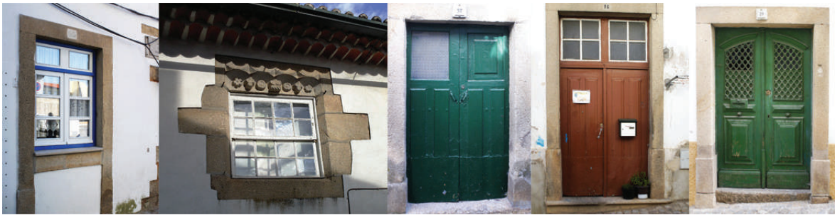
Figura 04.32 - Janela de batente com bandeira, janela de guilhotina, porta de duas folhas com postigo e envidraçada, porta de duas folhas com bandeira, porta engradada e almofadada, centro histórico de Castelo Branco, imagens da autora (mais exemplos na página 182 do apêndice 2)
