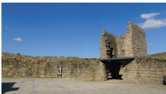
Figura 02.07 - Vista de um torreão da alcáçova, imagem da autora
