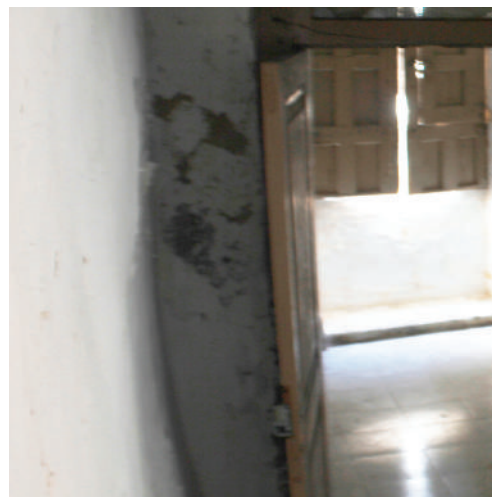
Figura 04.14 - Parede côncava, imagem da autora
