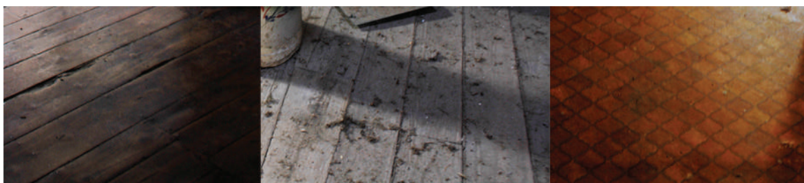
Figura 04.22 - Revestimentos do pavimento do 1º andar e sótão (soalho de madeira e soalho recoberto), imagens da autora
