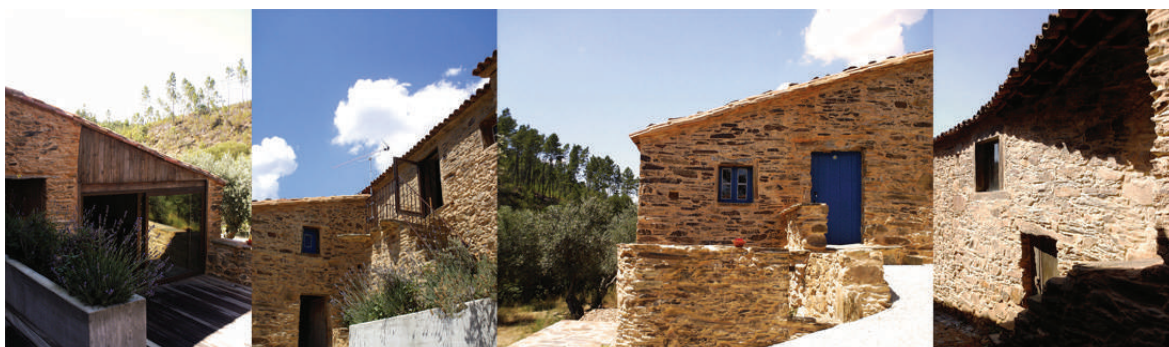
Figura 03.04 - "Xisto Sentido" visto pelo exterior, imagem da autora
