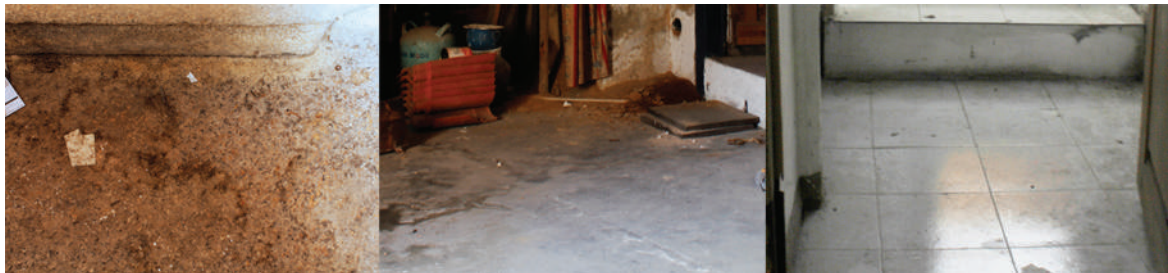
Figura 04.21 - Revestimentos do pavimento do rés do chão (laje de granito, aguada de cimento e cerâmico), imagens da autora
