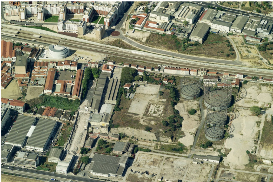
Fig. 36_Vista aérea do sítio de intervenção
