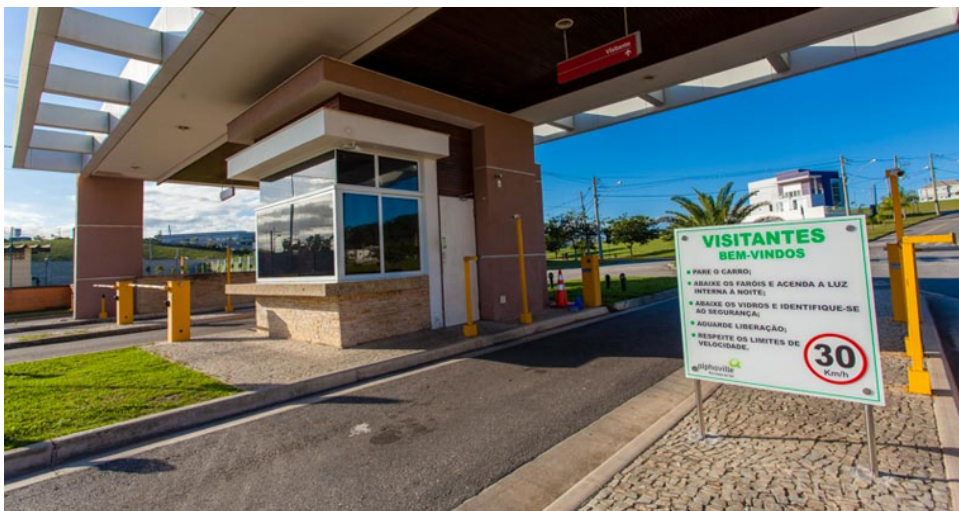
Figura 48 Placa de Aviso Portaria da Associação Alphaville Residencial 4 (2020, Disponível em: http://www.arcs.com.br/site/seguranca Acesso em: 12 de novembro de 2024)
