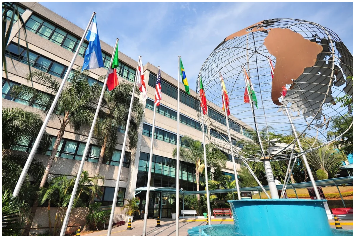
Figura 67 Fachada da Escola Internacional de Alphaville. (International Schools Partnership. s.d. Disponível em: https://internationalschoolspartnership.com/escola-internacional-de-alphaville-joins-isp/ . Acesso em: 8 de novembro de 2024.)
