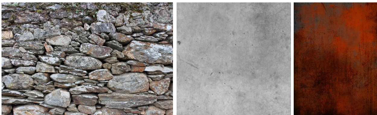
Fig. 136, 137 e 138 | Relação da matéria entre o novo e o existente – xisto, betonilha afagada e aço corten
