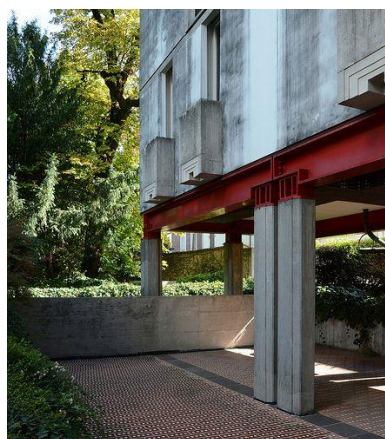
Fig. 5 | Viga Metálica, Casa Borgo, Vincenza
