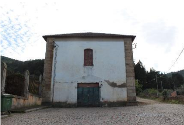
Fig. 13 e 14 | Exemplo de Arquitetura Desvirtuada, Igreja do Convento de São Francisco, Torre de Moncorvo
