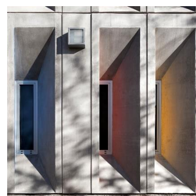
Fig. 47 | Superfície que reflete cor da superfície oposta, Escola Braamcamp Freire, CVDB arquitectos
