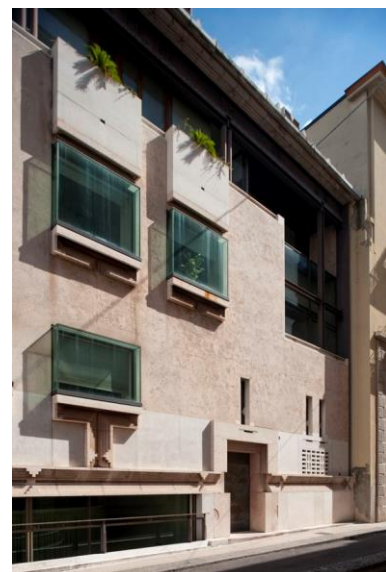
Fig. 32 e 33 | Exemplo de arquitetura contextual – Banca Popolare, Verona – Arq. Carlo Scarpa
