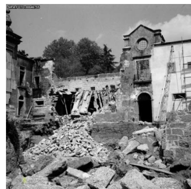
Fig. 51 | Demolição, Sta. Marinha da Costa
