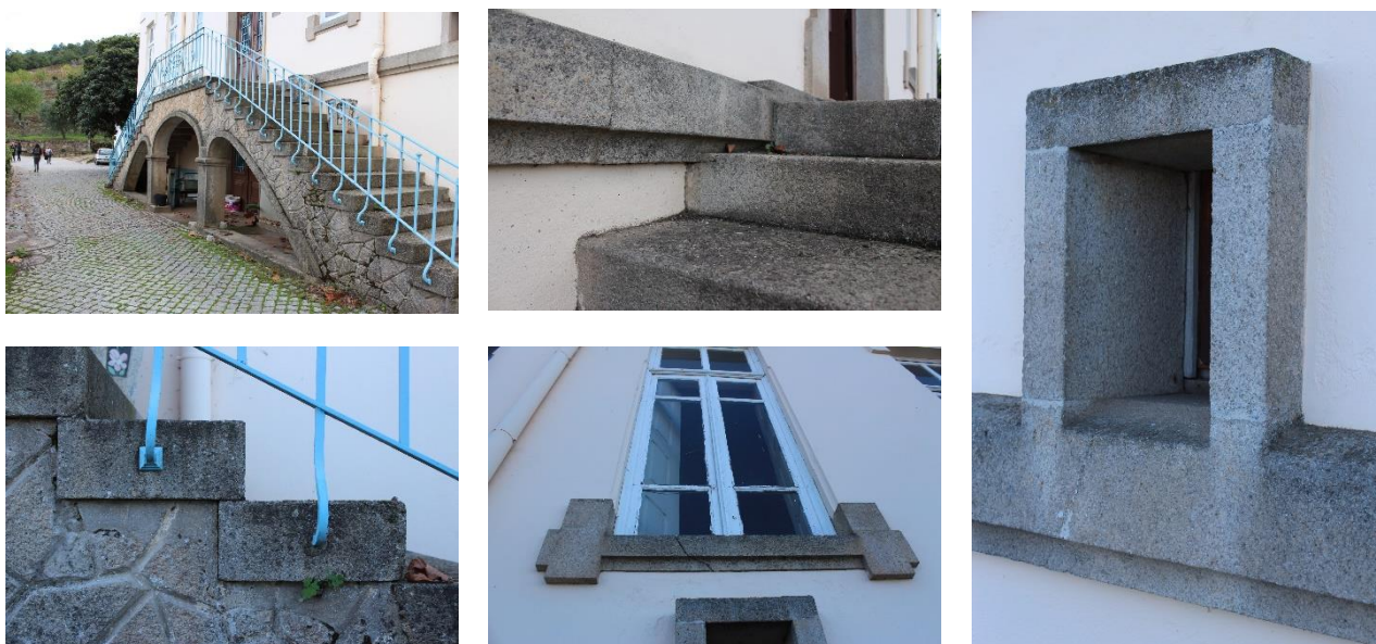
Fig. 98 | Elementos de granito existentes no antigo Asilo
