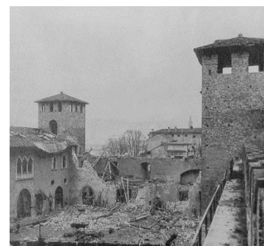
Fig. 62 | Processo de demolição, Museo di Castelvechio, Verona - Arq. Carlo Scarpa
