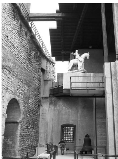
Fig. 71 | Descontinuidade entre o novo e o existente – Museo di Castelvecchio, Verona - Arq. Carlo Scarpa
