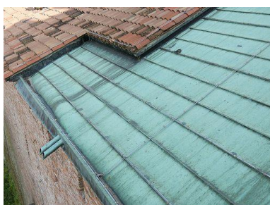
Fig. 72 | Descontinuidade entre o novo e o existente – Museo di Castelvecchio, Verona - Arq. Carlo Scarpa
