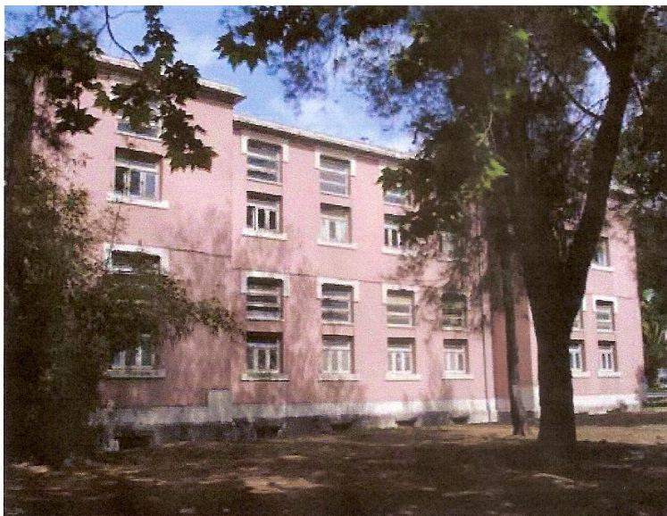
Vista Fachada Pavilhão 28
