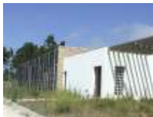
FIGURA C-25 – Subestação e Edifício de Comando do Parque Eólico de Chão Falcão.
