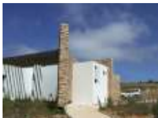
FIGURA C-24 – Subestação e Edifício de Comando do Parque Eólico de Chão Falcão.
