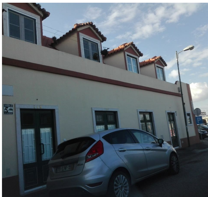
Figura 39 – Fachadas Após a Reabilitação Fonte: Proprietários do edifício
