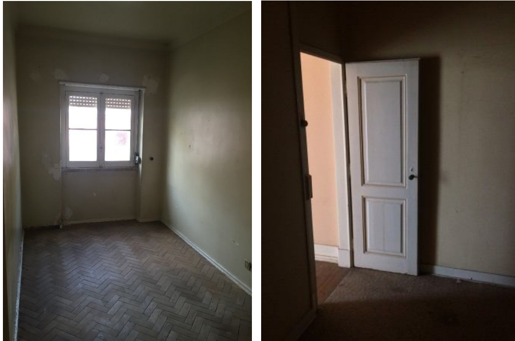
Figura 36: Interiores Antes da Reabilitação Fonte: Proprietários do edifício
