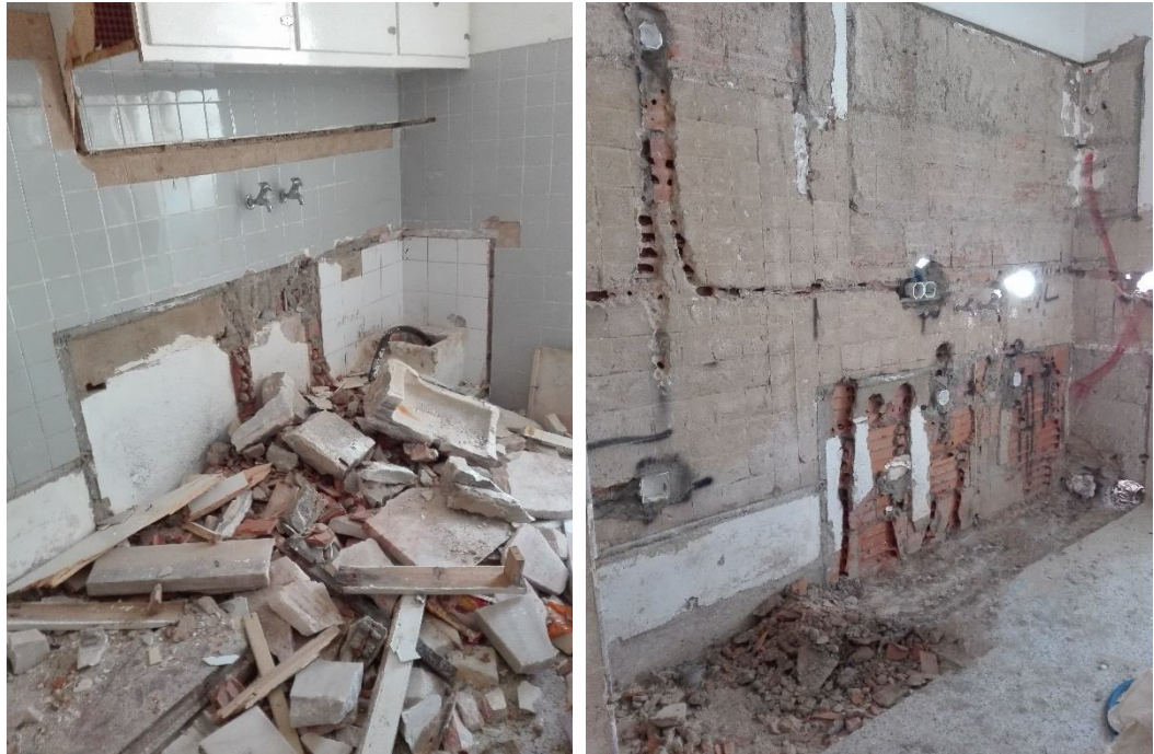
Figura 37: Interiores Durante a Reabilitação Fonte: Proprietários do edifício
