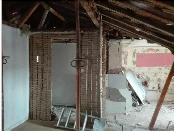
Figura 37: Interiores Durante a Reabilitação Fonte: Proprietários do edifício
