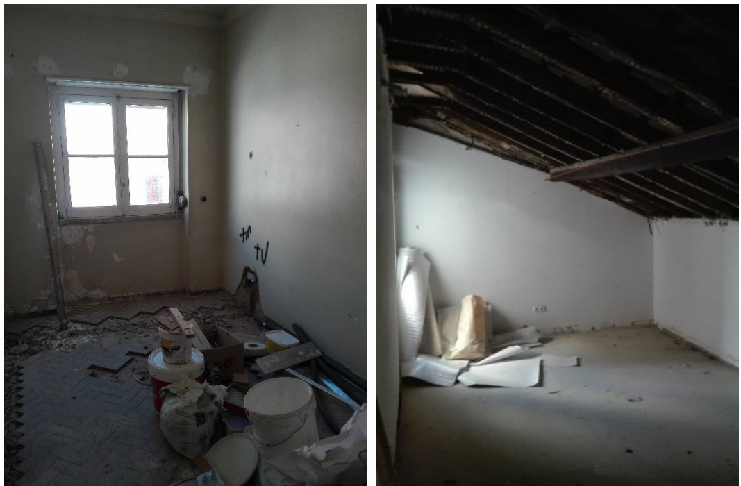
Figura 37: Interiores Durante a Reabilitação Fonte: Proprietários do edifício
