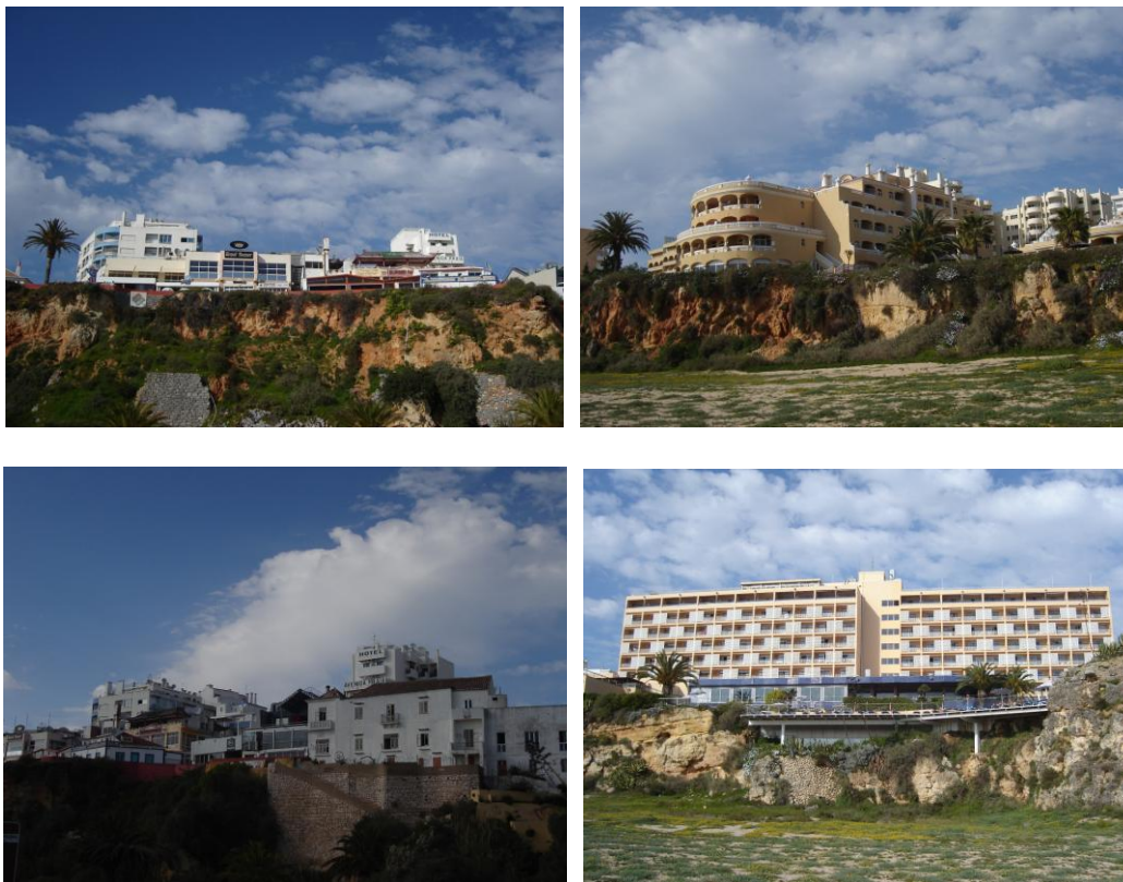
Figuras 23, 24, 25 e 26: Edificações para fins turísticos no topo das falésias
