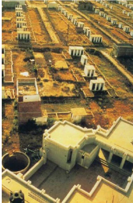
48 | Aranya Housing - Imagem aérea da construção
