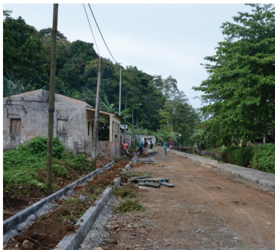
30 | Estrada a ser construída
