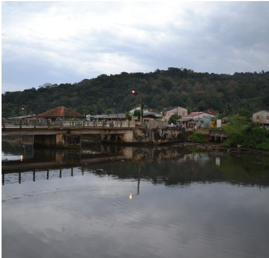
26 | Ponte sobre o Rio Papagaio
