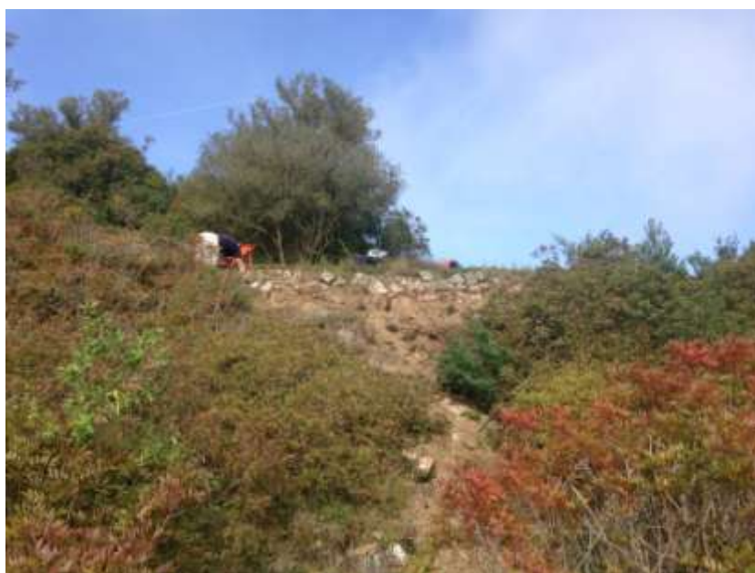
Fotografia 80 – Sondagem 9. Decorrer dos trabalhos de escavação da muralha.
