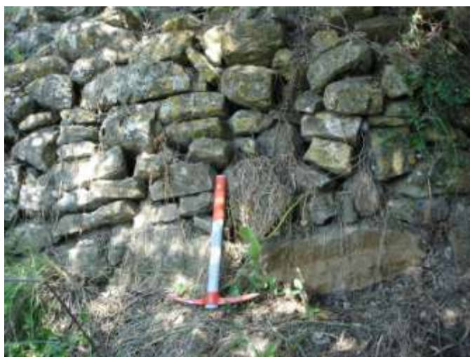
Fotografia 11 – Alçado de um dos taludes pétreos (Muralha) que delimitam a plataforma superior.
