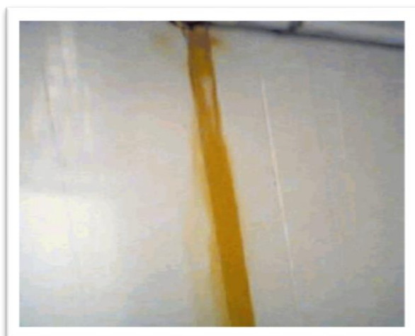
Ilustração 5 – Falha na higienização de uma das paredes da câmara de queijos (fotografia original)
