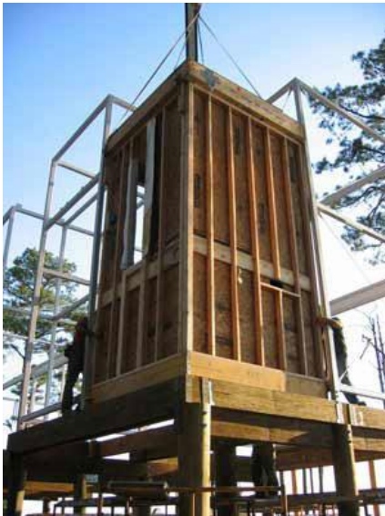
Figura 5.1.1 Construção da Loblolly House em Light Framing. Keiran Timberlake
