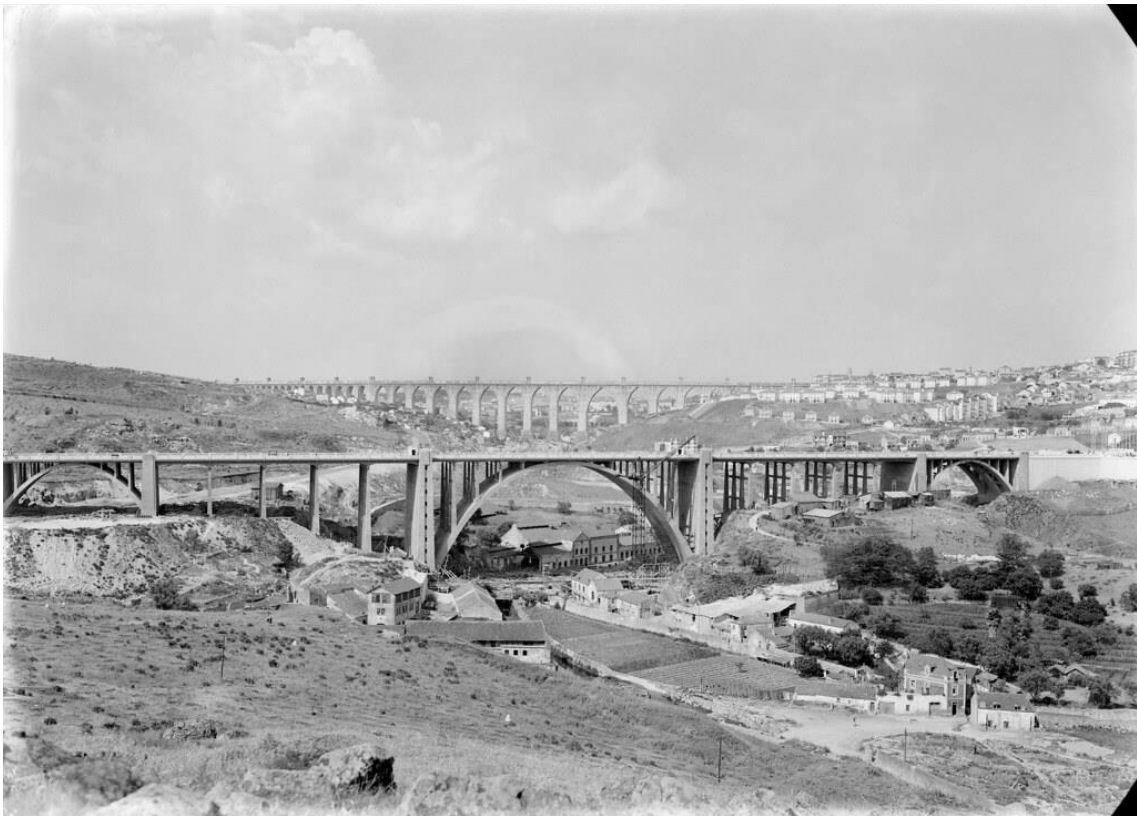
Viaduto Duarte Pacheco durante o período de construção. Fonte: Estúdio Horácio Novais
