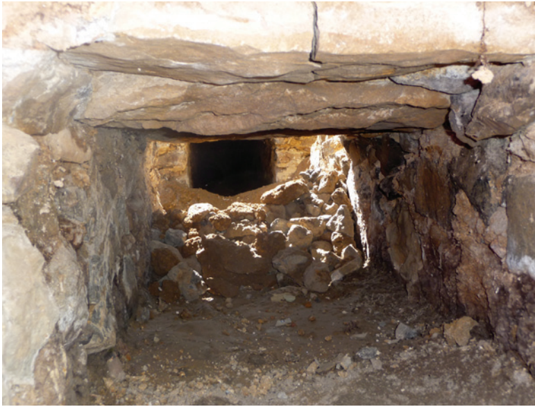
Figura 6 – Vista em perspectiva da caleira (U.E. 21 e U.E. 22)
