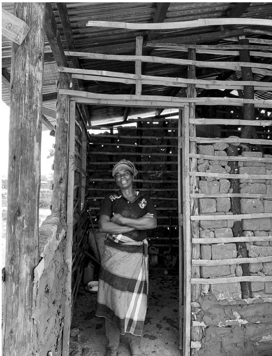
[3.18] Casa recém-construída, Dombe [4.01] Construção do Orfanato Xewa Sowé (página seguinte)
