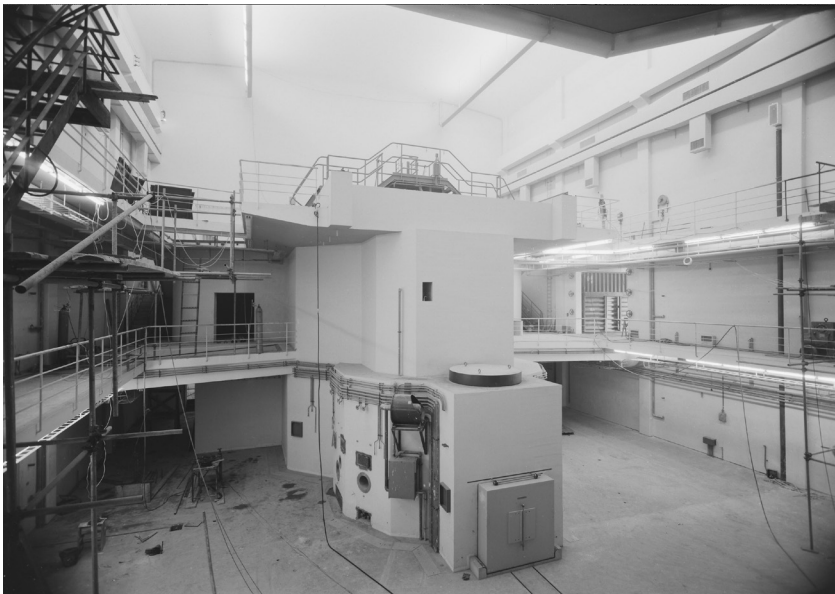
Figura 10.6 – Piscina do Reactor Português de Investigação.
