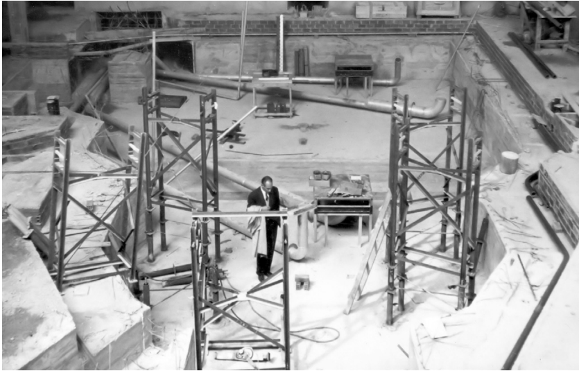
Figura 10.5 – Visita de Carlos Cacho, director-geral do LFEN entre 1959 e 1976, ao estaleiro do edifício do Reactor Português de Investigação.
