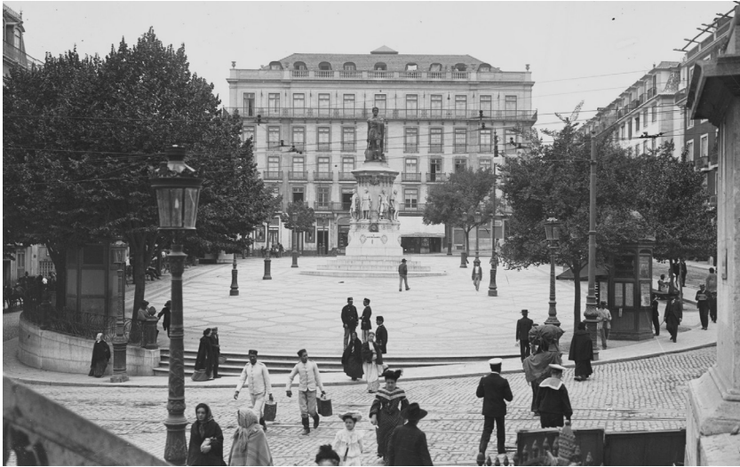
Figura 7.6 – Edifício onde se localizava a sede da Universidade Livre, na Praça Luís de Camões, Chiado.
