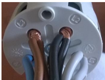
Figura 5.1:1: montagem dos cabos elétricos na ficha trifásica usando o código de cores standard.
