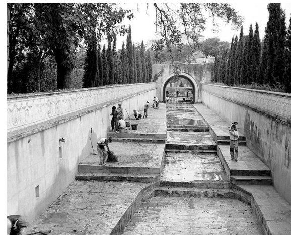
2. Canal de entrada
