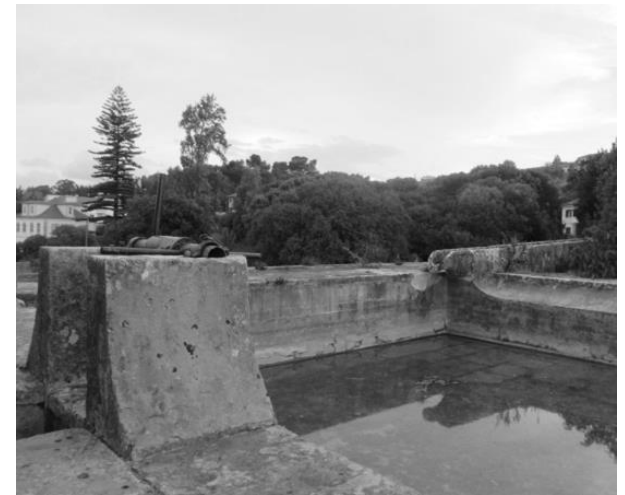
2. Tanque da Cascata
