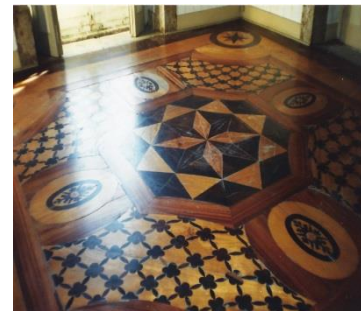
4.29. Pavimento de Madeira
