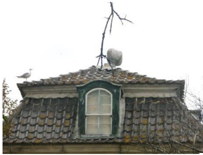
4.37. Cobertura de um Torreão
