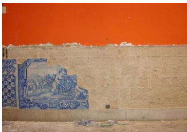
4.48. Sala de Entrada
