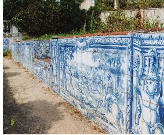
4.41. Muro com conversadeiras
