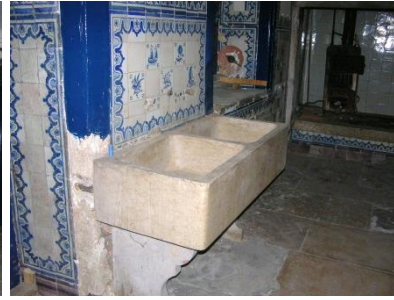
4.31. Lavatório em Pedra
