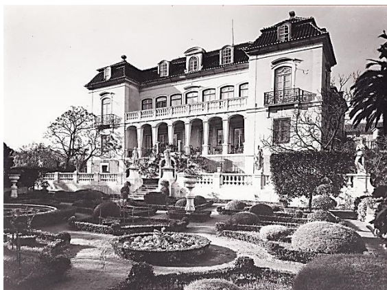
4.9. Palácio das Águias, Fachada Sul
