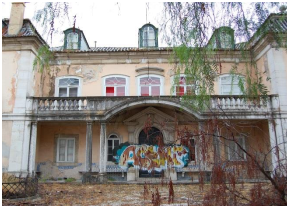
4.46. Fachada Nascente, Estado Actual
