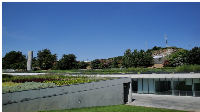
Figura 2 - Aspecto da ETAR de Alcântara
