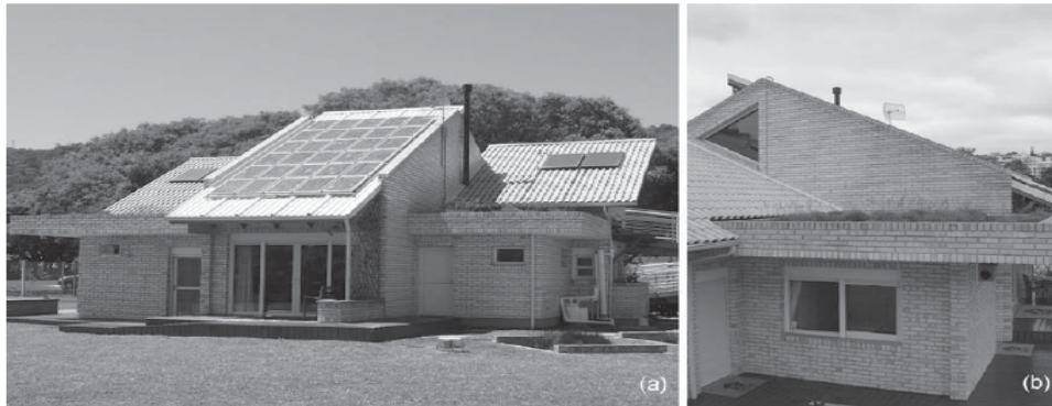
Figura 6 – Fachada norte (a) e quarto vista exterior (b) do edifício experimental. Fonte: Parizotto e Lamberts (2011)
