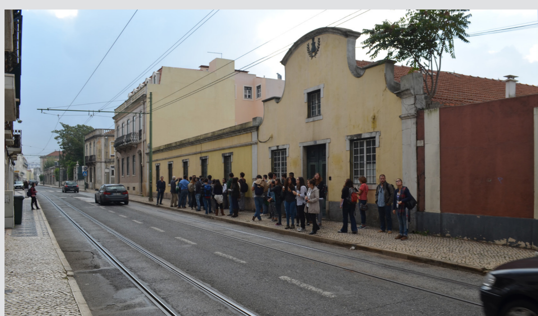
3 FACHADA DO ARMAZÉM NA RUA DA JUNQUEIRA
