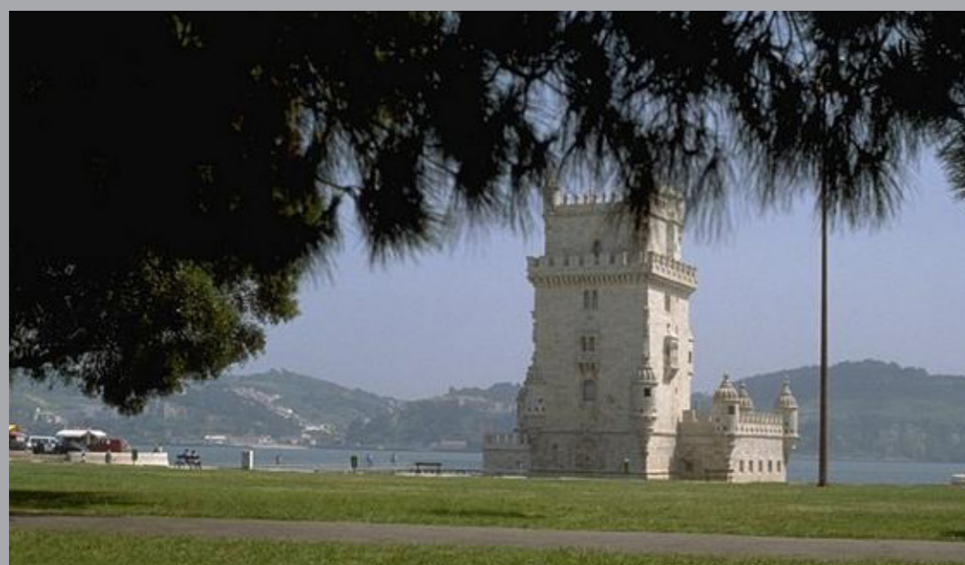
1 JARDIM DA TORRE DE BELÉM
