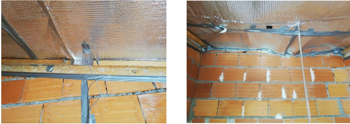
Figura 3.10: Aplicação do isolamento radiante na célula CT.
