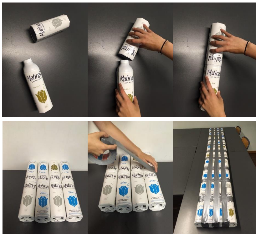
Figura 3.8: Montagem do isolamento Tetra Pak em conjuntos, para facilidade de aplicação no teto da célula de estudo.
