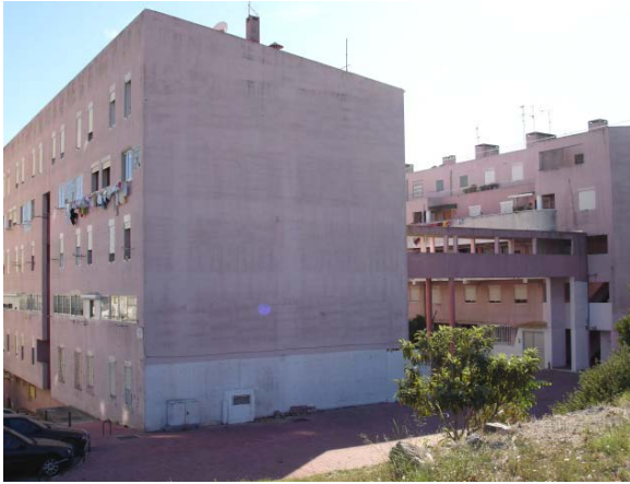
Fig. 29 | Edifício “Pantera cor-de-rosa”, Chelas.
