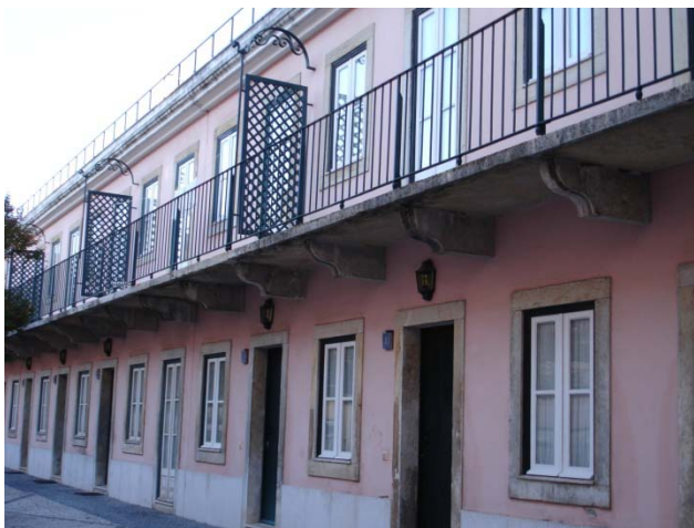
Fig. 12 | Pátio Bagatella, Lisboa, construído em 1890.
