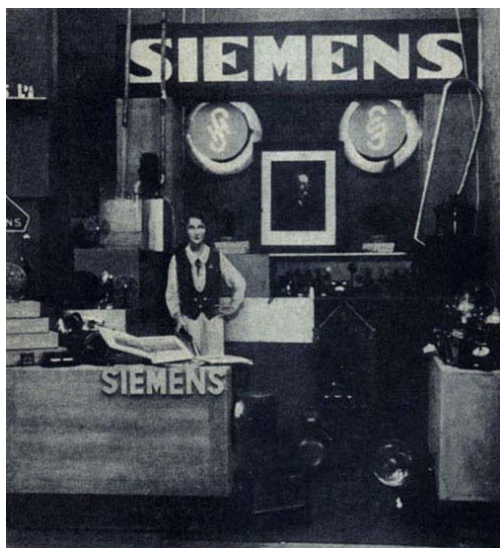
Fig. 80 | Stand da empresa Siemens na Exposição da Luz e Electricidade Aplicada ao Lar , 1930.
