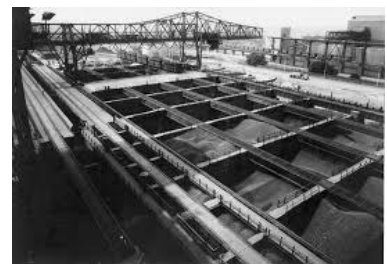
Figura 62 - Antiga área industrial “Thyssen-Hochofenwerkno, distrito de Mederic, Berlin. Antes do projeto de recuperação IBA – Emscher Park. Autor: Jürgen Dreide,
