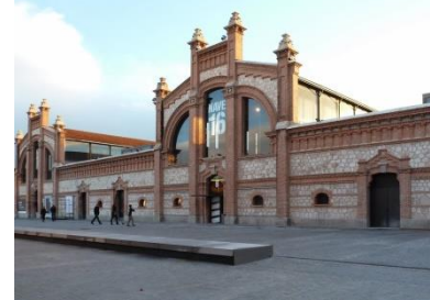
14. El Matadero e Nave 16, Madrid. Autor: OCIO KYMCO (2015)
