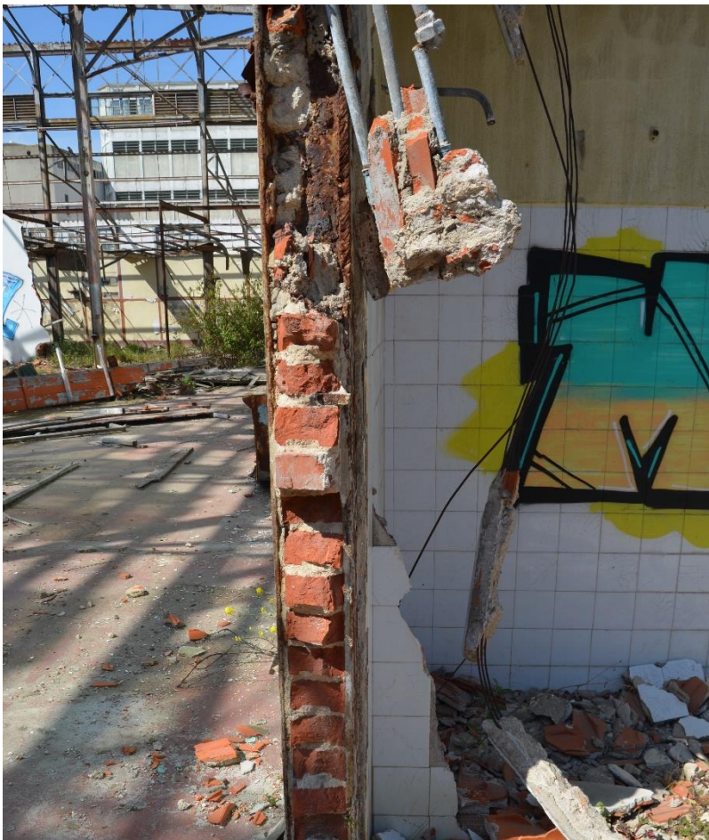
58. Pano de alvenaria original em parede exterior
