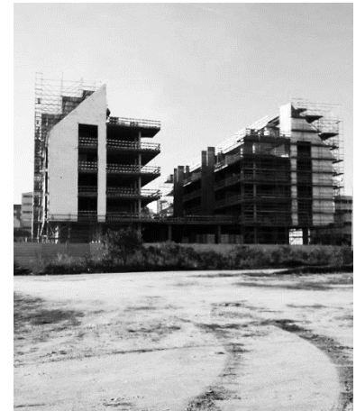
Figura 105 – Edifícios do Plano de Pormenor do Arquiteto Renzo Piano em construção (2017)
