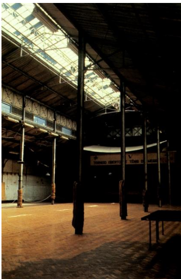
Figura 58 - Nave interior do edifício da Tabaqueira. Autor: Irene Buarque (1983)
