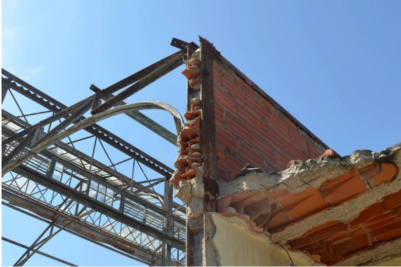
57. Estrutura e Alvenaria original de novos elementos
