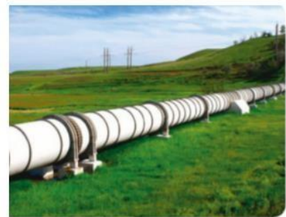
Fig.8 – Gasoduto. Fonte: Ribeiro, E.; Lopes, T. R.; Custódio, S. & Ribeiro, V. (2019, p.170).
