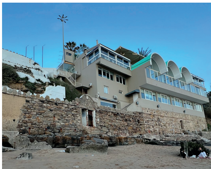
121. e 122. De cima para baixo; Fotografia da escadaria existente, 2024; Fotografia da pré-existência da antiga muralha, 2024;
