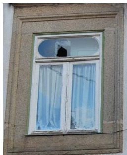
figura 7.10 – Janela de peito com caixilhos de madeira.
