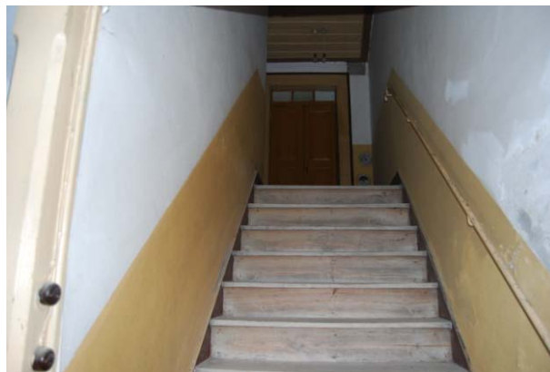
figura 7.8 –Escadas em madeira.
