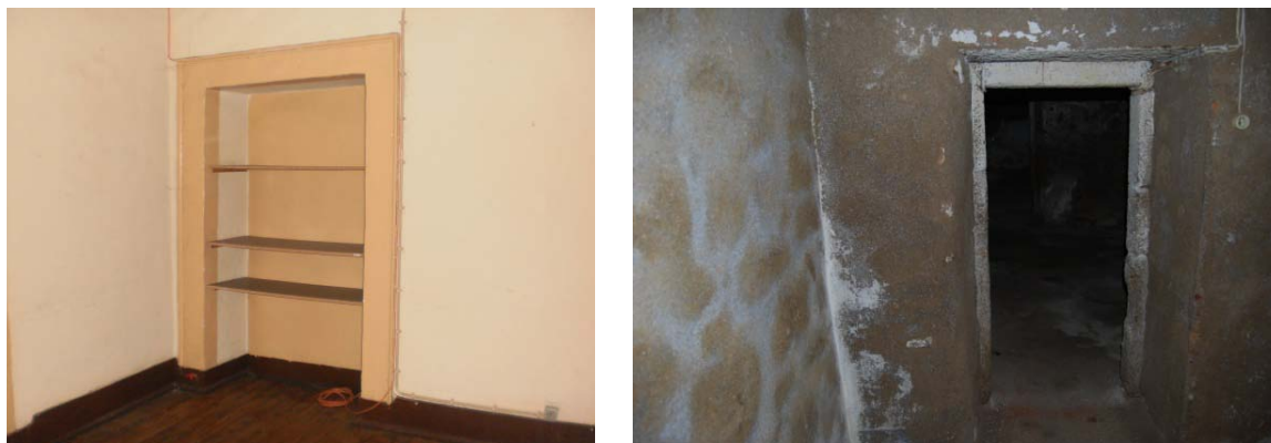
figura 7.2 – Paredes interiores pré-existent (no 1º andar e rés-do-chão).
