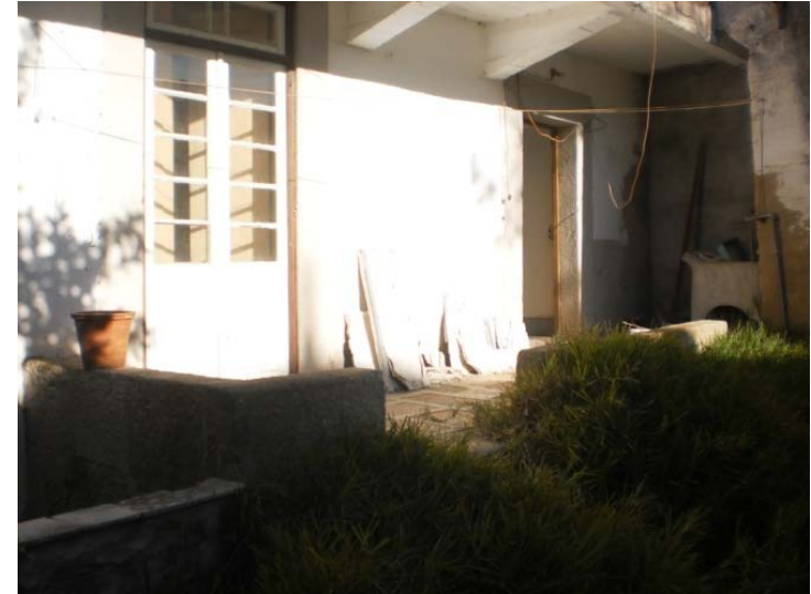
figura 8.22 - Espaço exterior do pré-existente.
