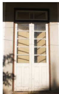
figura 7.11 – Janelas de sacada de batente.
