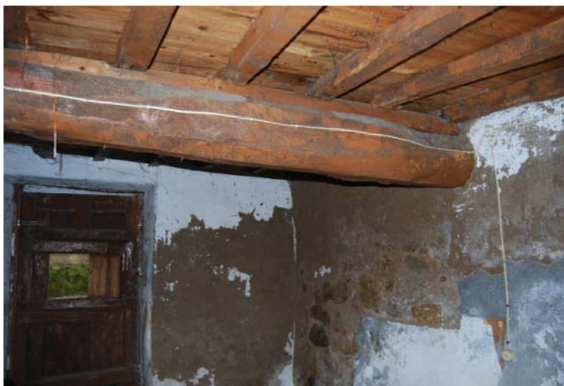
figura 7.1 –Alvenaria de pedra, com os pisos de travejamento de madeira.
