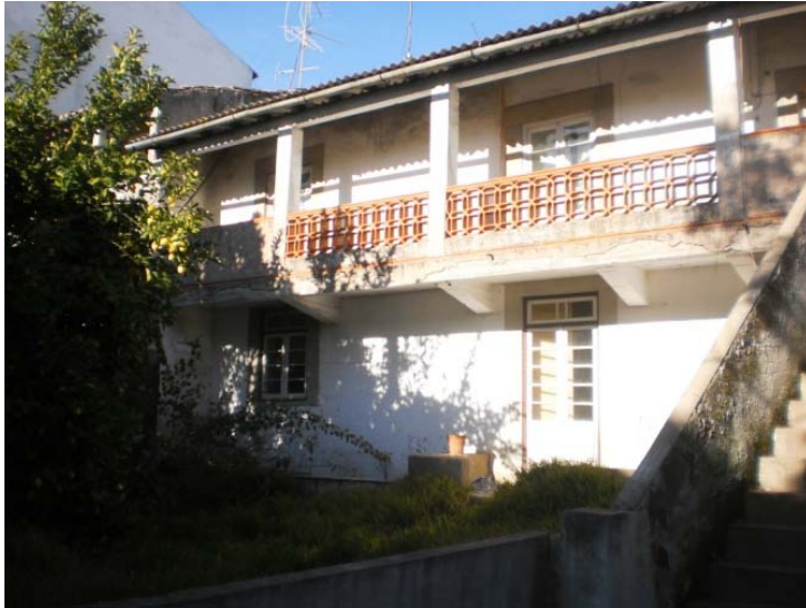
figura 8.21 - Espaço exterior do pré-existente.
