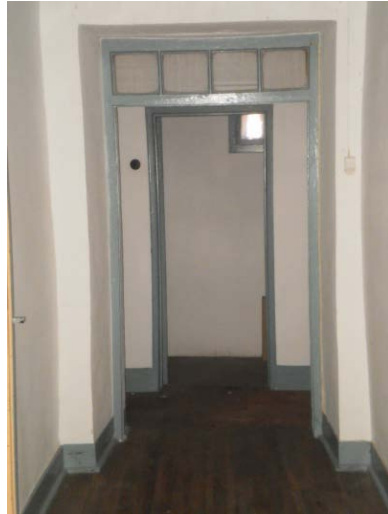
figura 8.17 -Corredor pré- existente.
