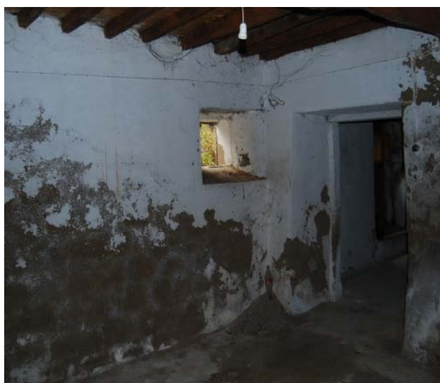
figura 7.4 – Paredes com salitre
