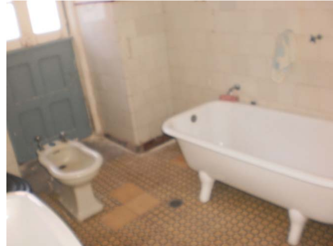
figura 8.9 –Casa de banho pré-existente.
