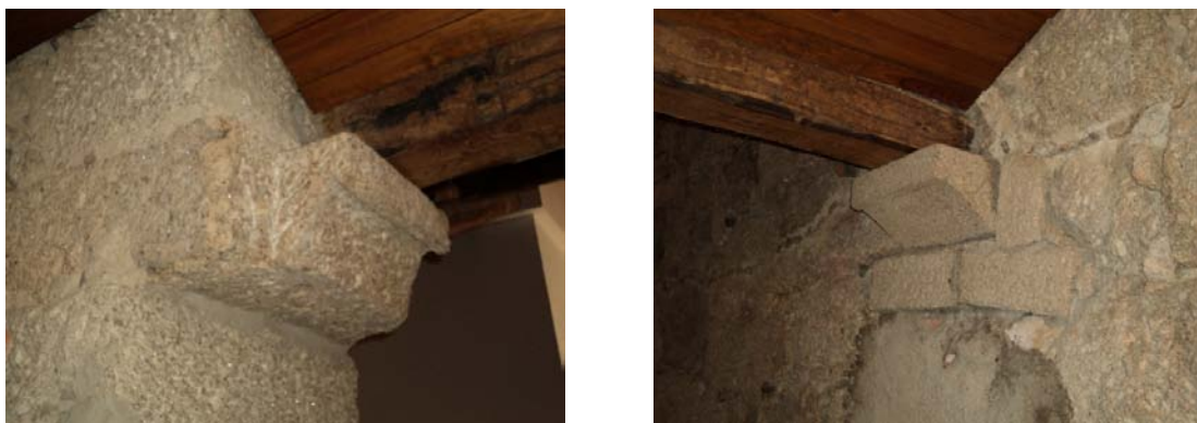
figura 5.3 – Cachorros de pedra, salientes no interior da habitação.
