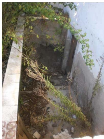
figura 6.5 – Escadaria do rés-do-chão de acesso ao quintal.
