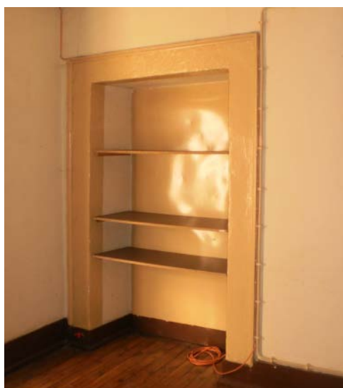
figura 7.3 – Paredes em gesso.
