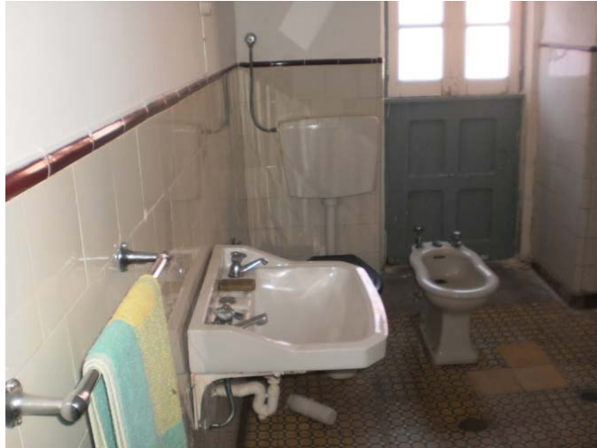
figura 8.83 –Casa de banho pré-existente.
