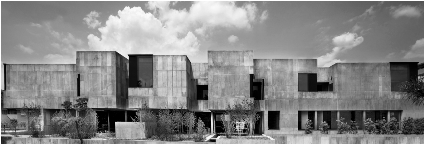
Fig 50. Fachada exterior da escola, Harunori Noda
