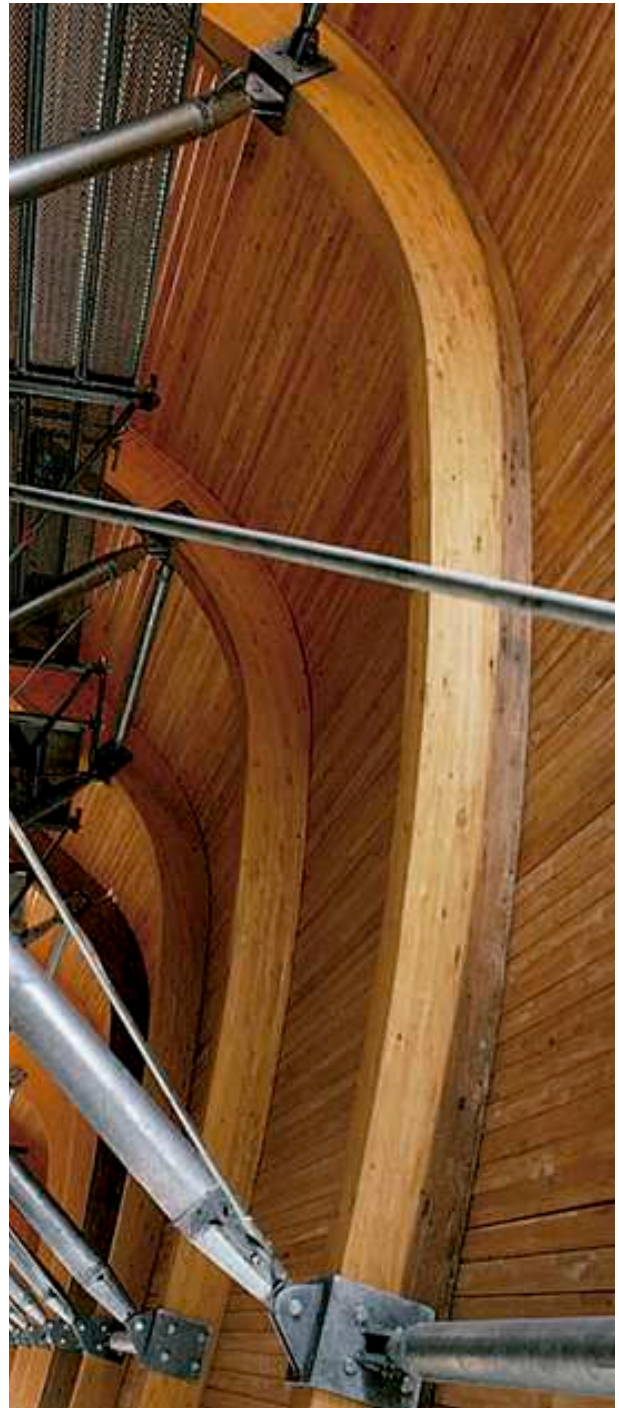
Fig 71. Interior da fachada com estrutura mista de vigas de madeira laminada e nervurada de aço, Moreno Maggi
