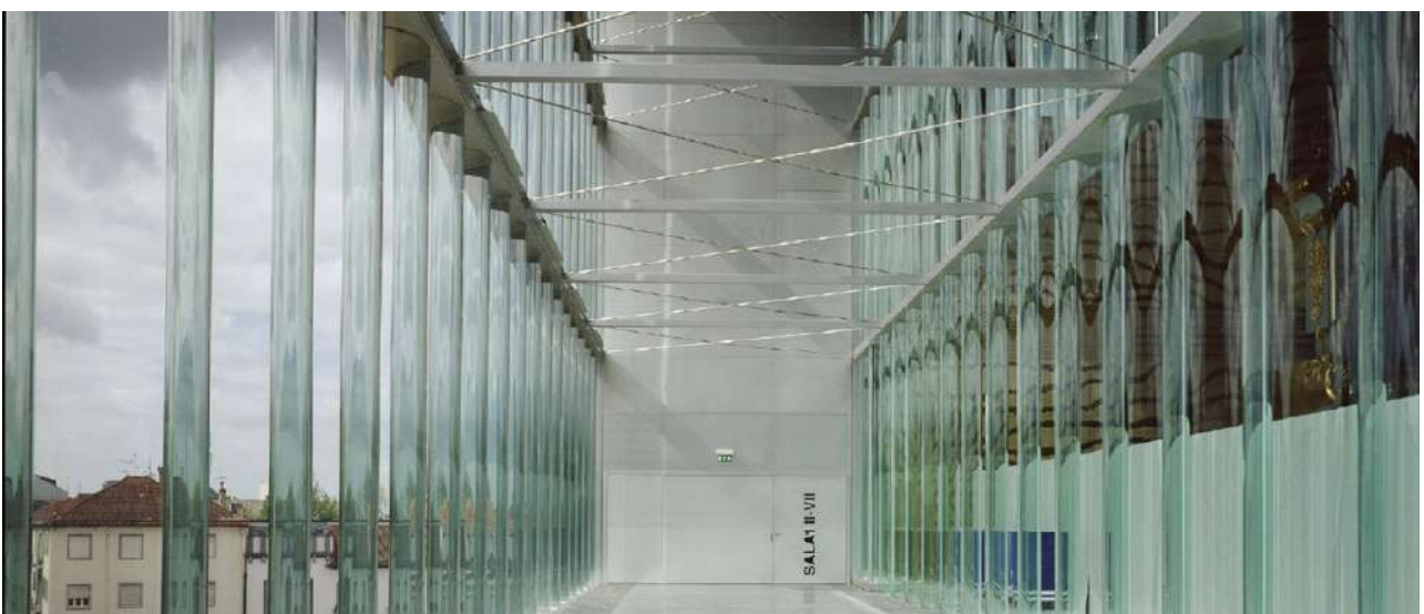
Fig 60. Espaço de transição para o grande auditório com o vidro duplo ondular a separar os espaços, Philippe Ruault
