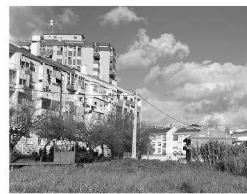
FOTOGRAFIA NO BAIRRO OLAIO ÁREA EM DESUSO
