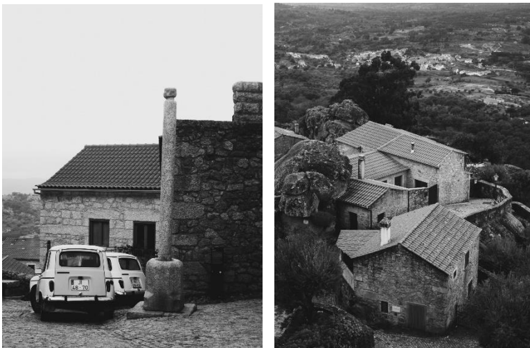
Fig 8 e 9 - Aldeia Histórica de Monsanto, interior de vila e vista do miradouro do forno, respetivamente.
