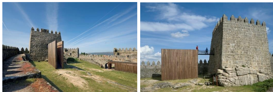
Fig. 44 e 45 - Castelo de Trancoso - “As intervenções cirúrgicas e de pequena escala - consistindo em “instalações” em vez de edifícios [...] procurando uma harmonia e um equilíbrio em relação à estrutura antiga.” Gonçalo Byrne.
