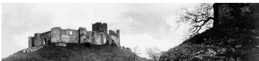
Fig. 68 - Exterior do Castelo de Pombal, degradado. Data incerta.
