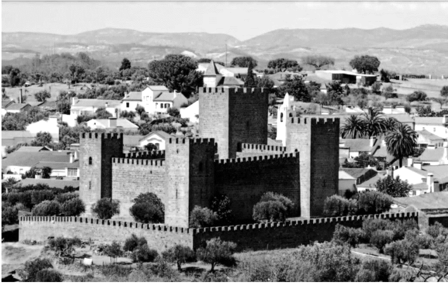
Fig. 48 e 49 - Fortificação de Amieira do Tejo, com corte da Torre de Menagem, após intervenções efetuadas.
