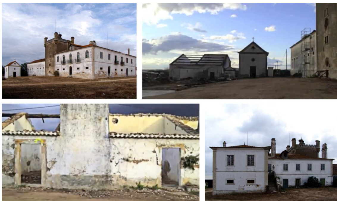
Figura 39. Edifício da Herdade de Torre de Palma antes da reabilitação (imagens adaptadas do vídeo “torre de palma” de José Clemente disponível em youtube.com)
