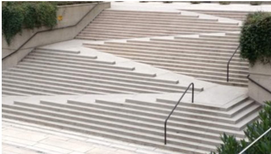
Figura 52. Escadas/Rampa em Robson Square, Vancouver por Arthur Erickson em 1980 (imagem adaptada de accessibilitymatters.ca )
