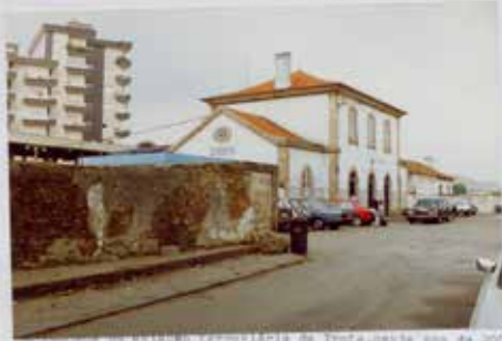
A FACIADA PRINCIPAL DA ESTAÇÃO DE TROIA
