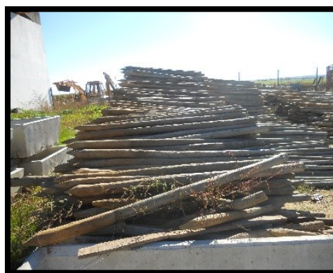
Figura 24 – Postes de madeira tratada
