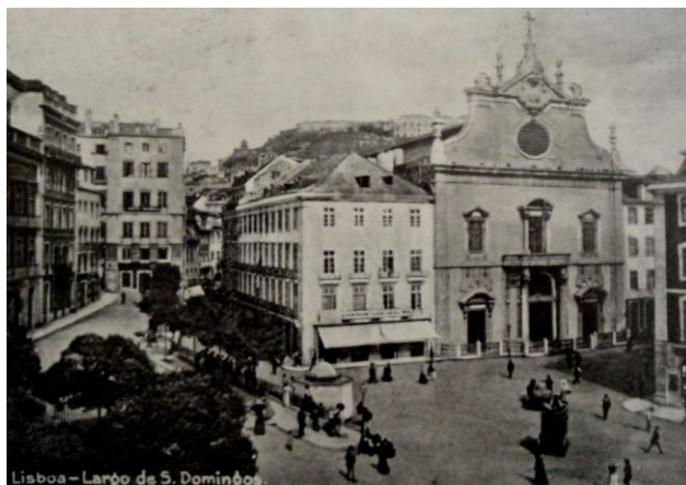
Fig. 55 Igreja de S. Domingos rodeada por marcos
