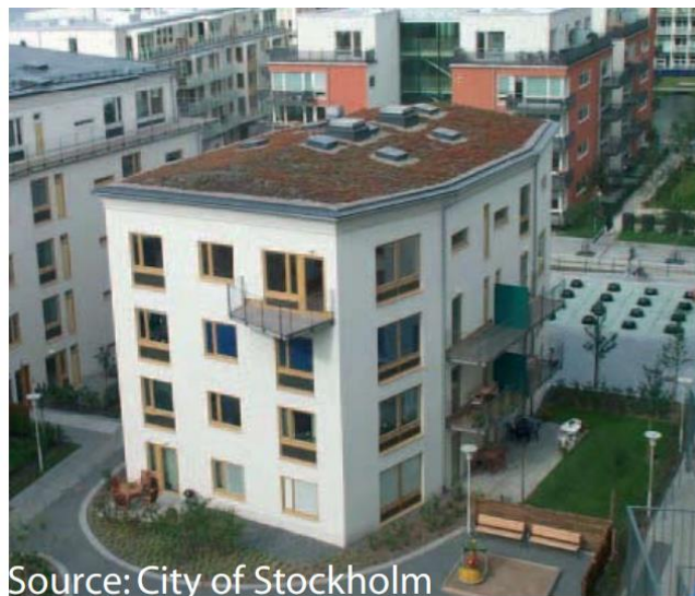
Figura 5.6- Revestimento no Boavista
