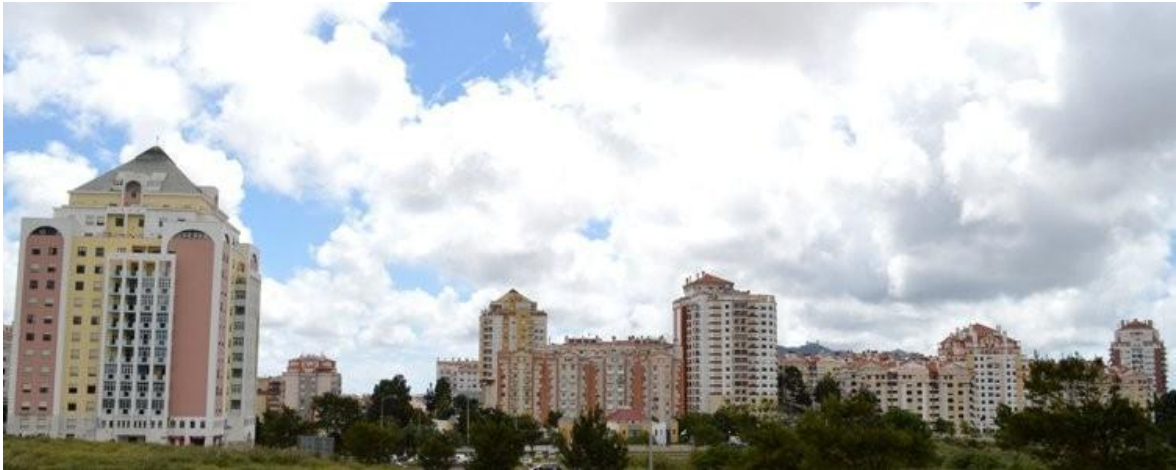
Figura 3.5 - Edifício na Tapada das Mercês.
