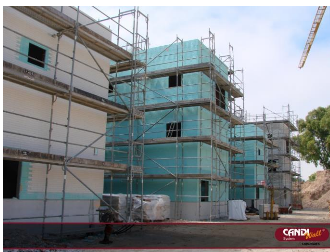
Figura 5.2- Revestimento no Boavista
