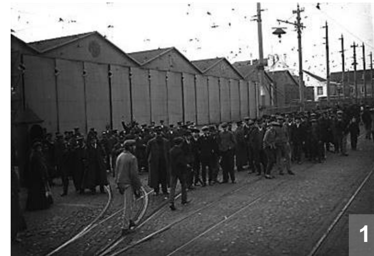
Estação de Eléctricos de Santo Amaro
