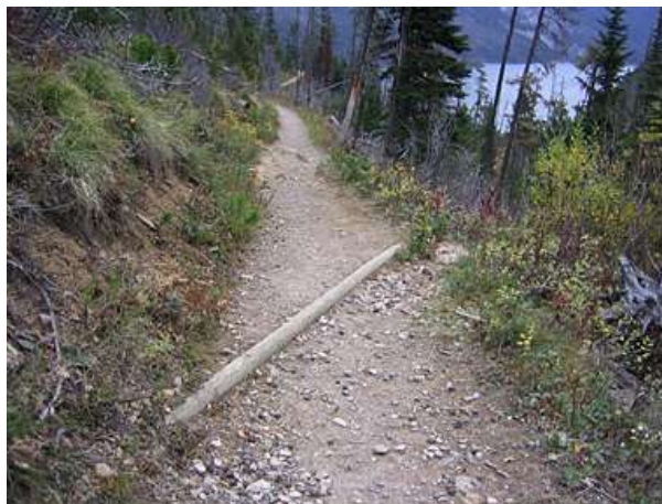
Figura 37 - Estrutura de drenagem instalada ao longo do trilho
