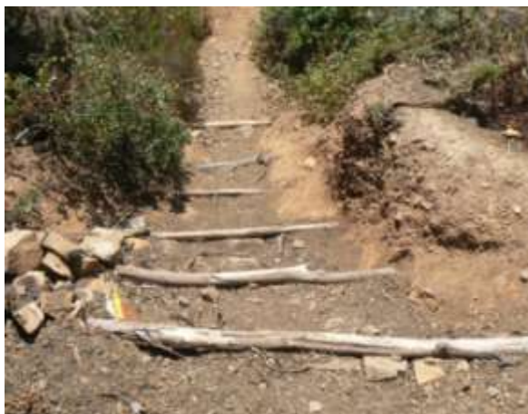
Figura 38- Controle do declive através da construção de escadas utilizando material da área envolvente (PNSC)
