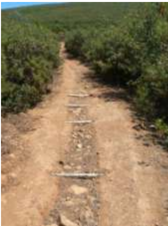
Figura 36 - Enchimento de canal com material de diferentes granulometrias (PNSC)
