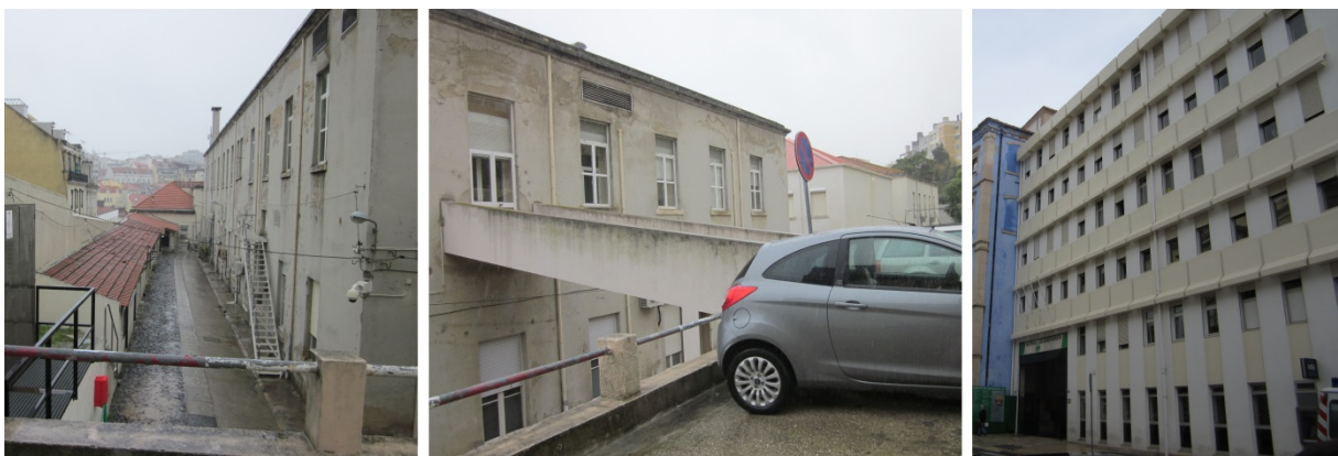
figura 32. “Edifício do coração”, construído em 1905 (à esquerda e ao centro); bloco das consultas externas, construído entre 1971 e 1983 (à direita)
