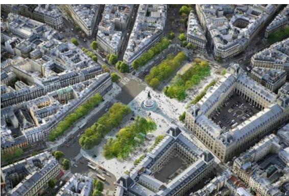
Imagem 9. Vista aérea da praça, o depois, Imagem de Clément Guillaume.
