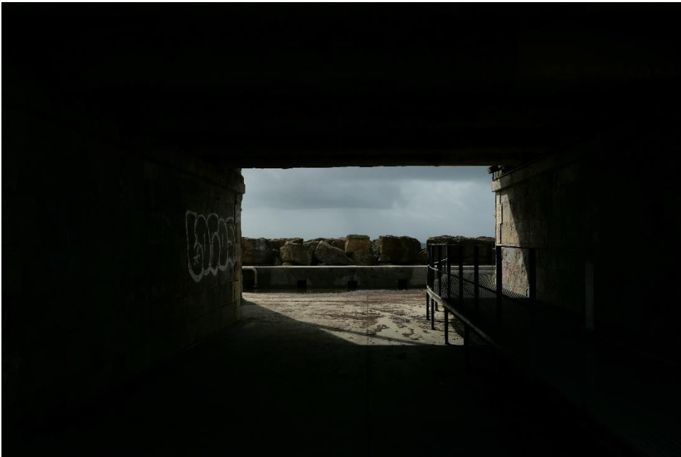
Fig. 59 – Túnel atual de acesso à praia de Cruz Quebrada
