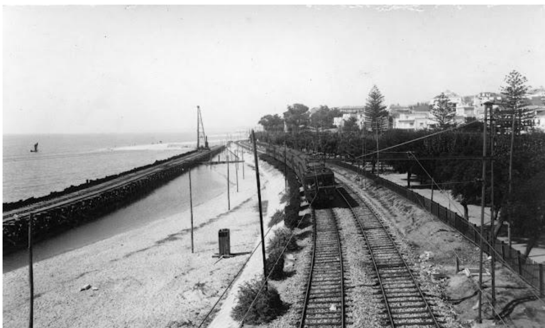
Fig. 15- Linha de Cascais durante a ripagem da linha na zona de Dafundo-Cruz Quebrada, 1938
