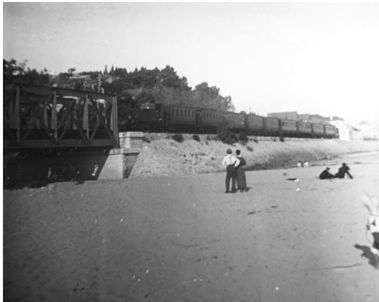
Fig. 13 - Comboio rebocado por locomotiva na Ponte de Cruz Quebrada, 1915
