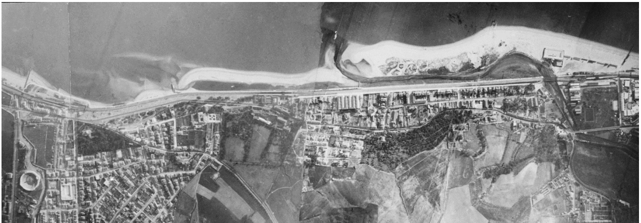
Fig.03 - Vista aérea entre Cruz Quebrada e Algés, antes das obras de canalização da Ribeira do Jamor e da regularização da Praia do Dafundo, séc. XX
