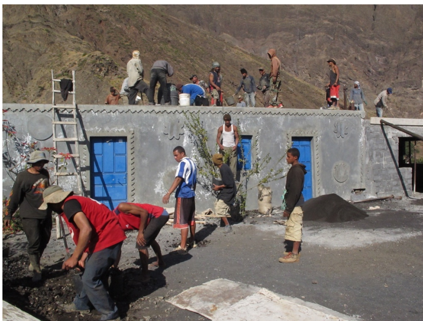
Figura 9- Djunta món na colocação de betão numa casa 28
