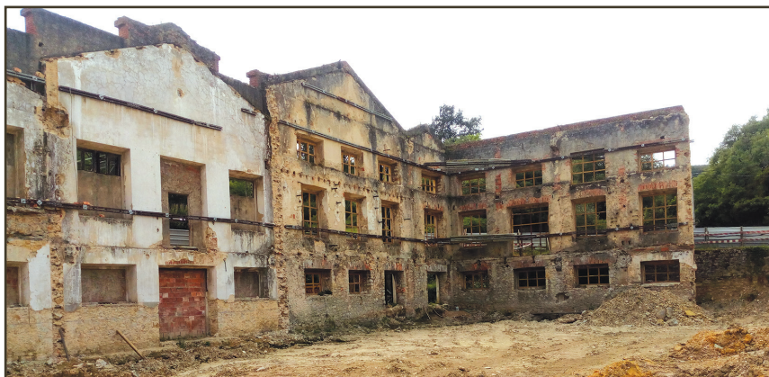
FIGURA VII Preservação das paredes sul e poente do antigo edificado industrial, Fotografia do autor, 2017.
