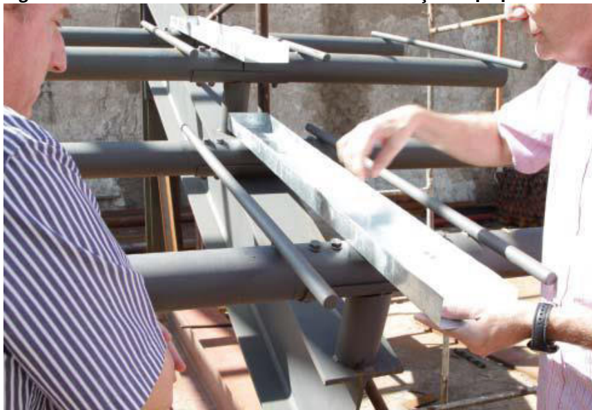
Figura 35 – Cobertura da Arena do Morro com definição da pequena calha.
