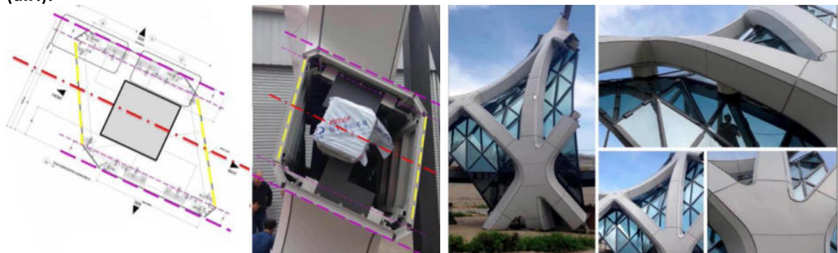
Figura 54 - Mock-ups do revestimento e estrutura (esq.) e da estrutura, revestimento e cortina de vidro (dir.).
