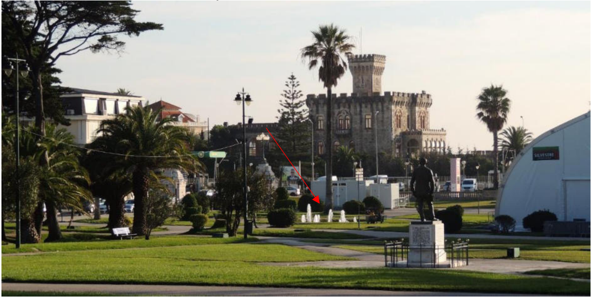
Figura 132 – Vista da área de intervenção a partir da fonte central dos Jardins do Estoril.
