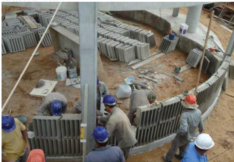
Figura 40 – Estrutura de concreto das paredes, durante o recebimento dos blocos de concreto.
