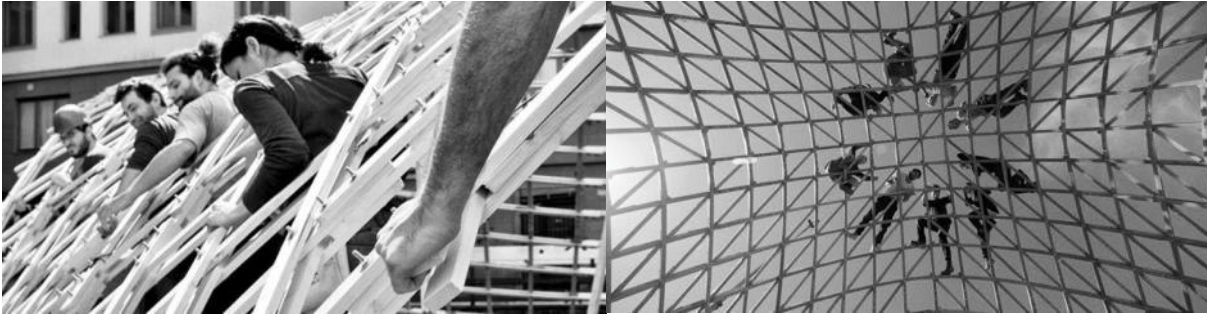
Figura 30 – Montagem da Toledo Gridshell pela equipe (esq.), e equipe no topo da estrutura (dir.).
