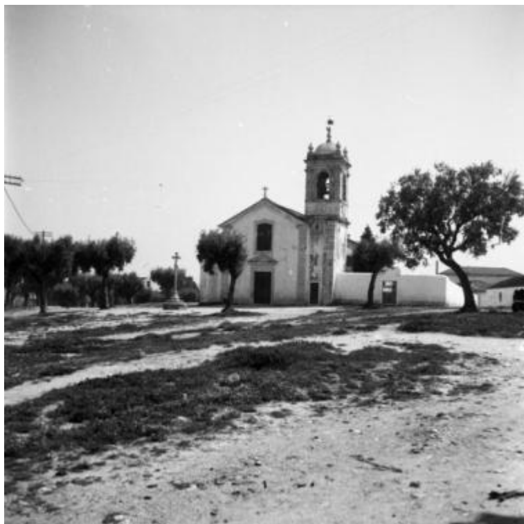
Fotografia 1 -Fachada Principal da igreja de S. Bartolomeu da Charneca, Lisboa 1959. Fot. Judah Benoliel (1890-1968). http://arquivomunicipal2.cm-lisboa.pt .
