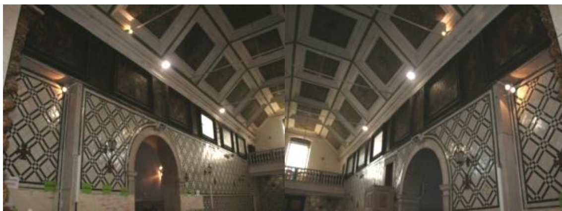
Fotografia 8 - Igreja de S. Bartolomeu da Charneca, séc. XVII, Lisboa.
