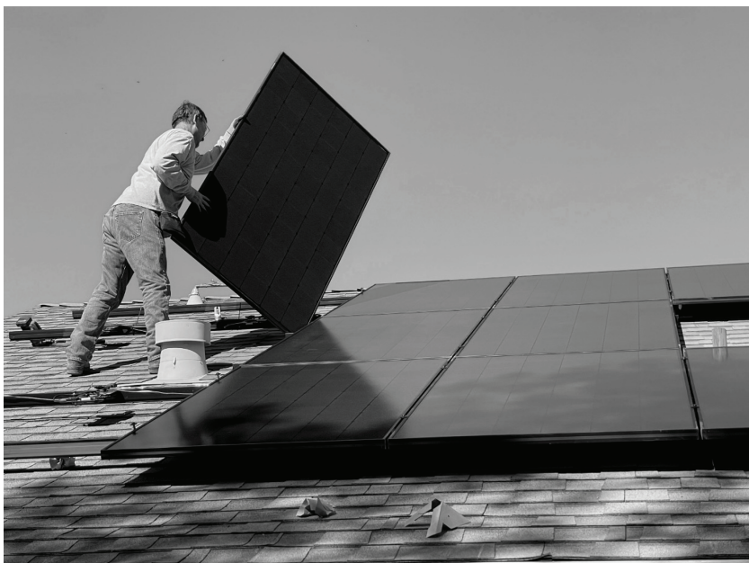
Imagem 2.1 – Instalação de painéis solares fotovoltaicos em telhados residenciais
