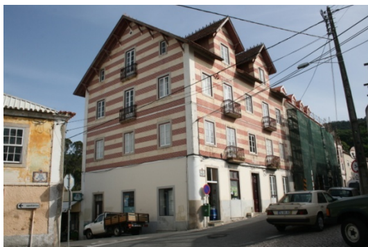
Figura 22 | Vista geral do edifício
