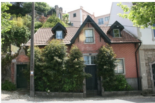
Figura 27 | Vista geral - fachada norte
