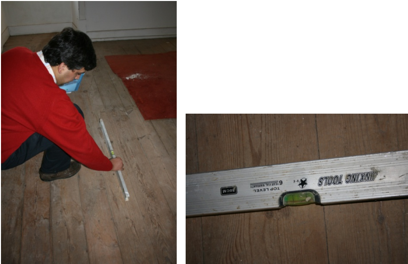
Figura 97 | Verificação da inclinação no pavimento com o auxílio de uma régua de nível
