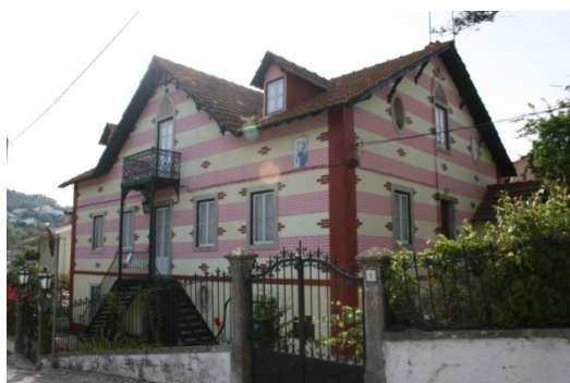
Figura 18 | Fachada principal alterada
