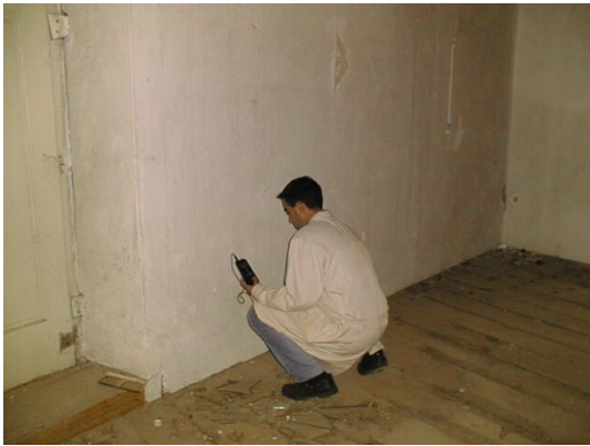
Figura 69 | Medição da humidade numa parede (Disponível em: www.oz-diagnostico.pt/ )
