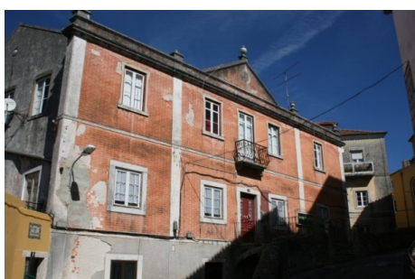
EDIFÍCIO 9 – Rua da Biquinha
