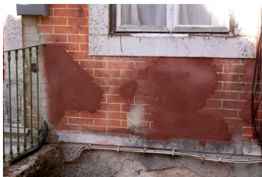
Figura 34 | Intervenção pontual de correcção
