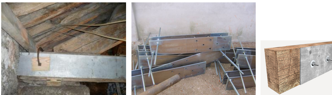
Figura 96 | Reforço das ligações da estrutura de madeira com chapas metálicas
