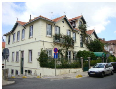
EDIFÍCIO 8 - Rua Prof. Dr. Alfredo da Costa
