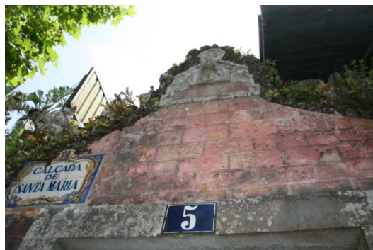
Figura 28 | Pormenor do acesso secundário
